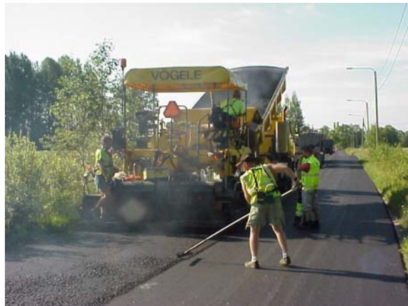
Kuva 2. Kuumalla kesäilmalla tienpäällystäjien suojavaatetus kevenee ja altistumista voi tapahtua myös ihon kautta hengitysilman lisäksi.
