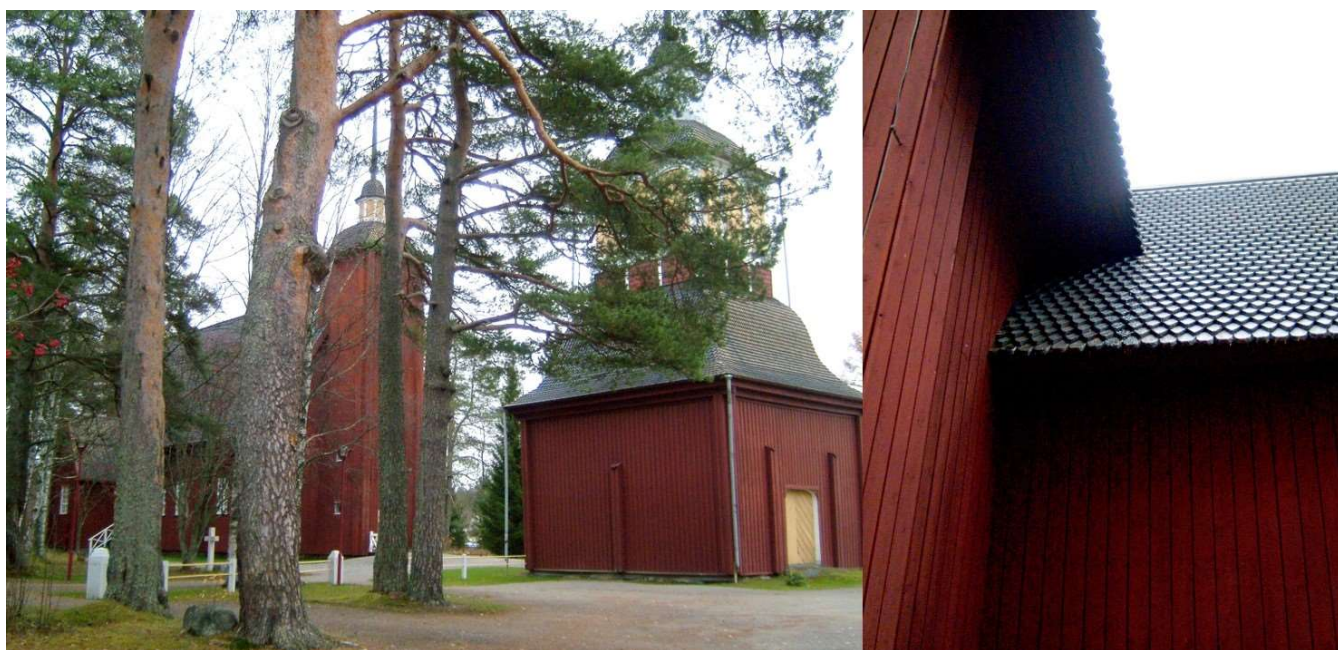
Utajärven kirkko: oikealla lähikuva katosta, jossa on käytetty tervaa suojaukseen (Kuvat: Esa Heikkinen).
